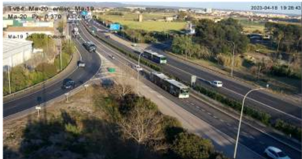
Bus saliendo del carril BUS-VAO para evitar problemas de trenzado al tener que parar en el palacio de Congresos
